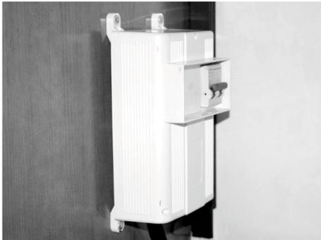
Abb. 3: Hauptschalter (FI-Schutzschalter)
