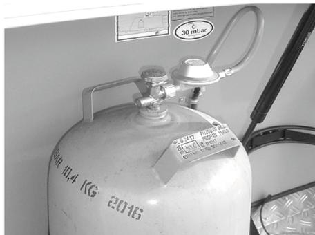
Abb. 68: Gasflasche mit Niederdruckregler und Niederdruckschlauch
